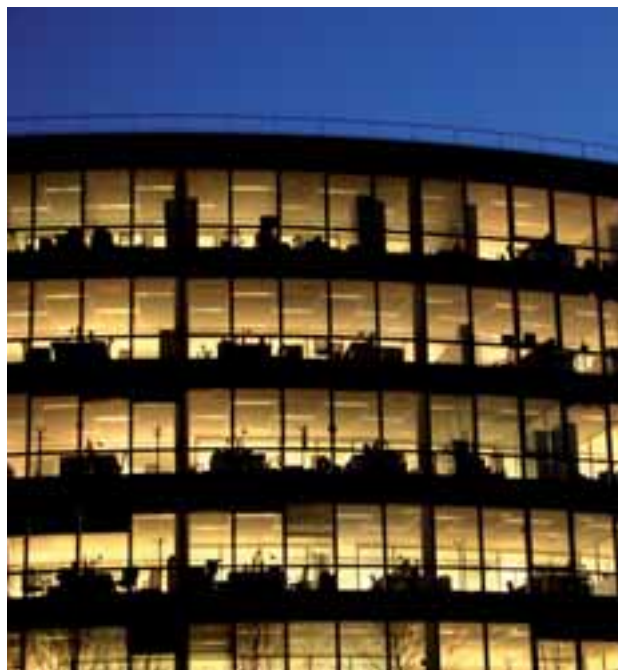
À proscrire: l'éclairage nocturne des bureaux.
